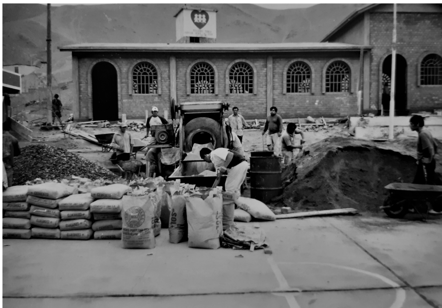
Fotografía 72. Construcción de la capilla escolar. Fuente: Colegio Fe y Alegría N. 12, 1996.
