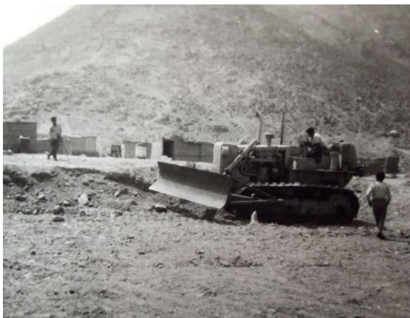
Fotografía 57. Nivelación de terreno. Fuente: Colegio Fe y Alegría N. 11, 1971.
