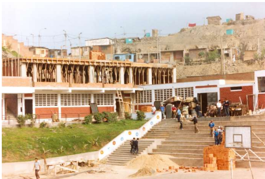
Fotografía 87. Techado de segunda planta. Fuente: Colegio Fe y Alegría N. 13, 2003.
