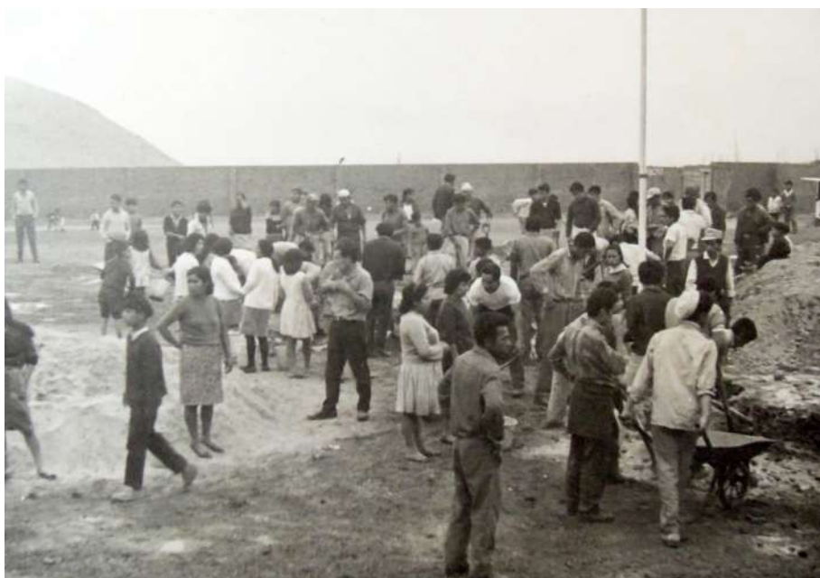
Fotografía 56. Nivelación de patio central. Fuente: Colegio Fe y Alegría N. 11, 1970.
